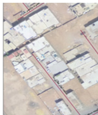
تخلفات ساختمانی باشد.
