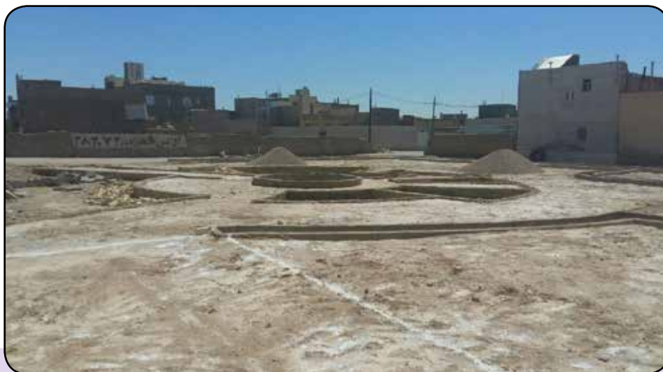
پیاده روسازی و احداث پارک درون محله ای
