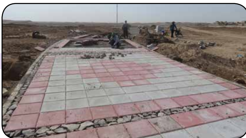
کف سازی پارک حسن آباد
