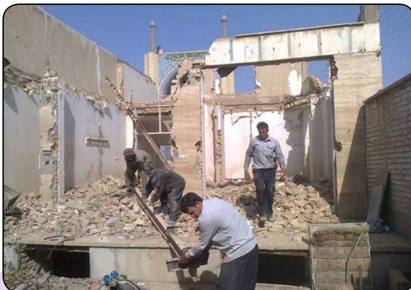
آزادسازی جهت احداث پارکینگ درون محله‌ای
