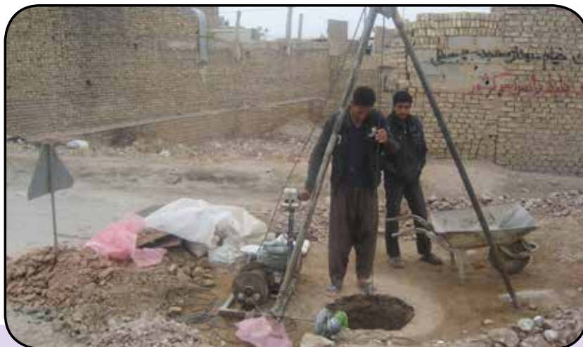
حفر چاه جذبی جهت دفع آب‌های سطحی
