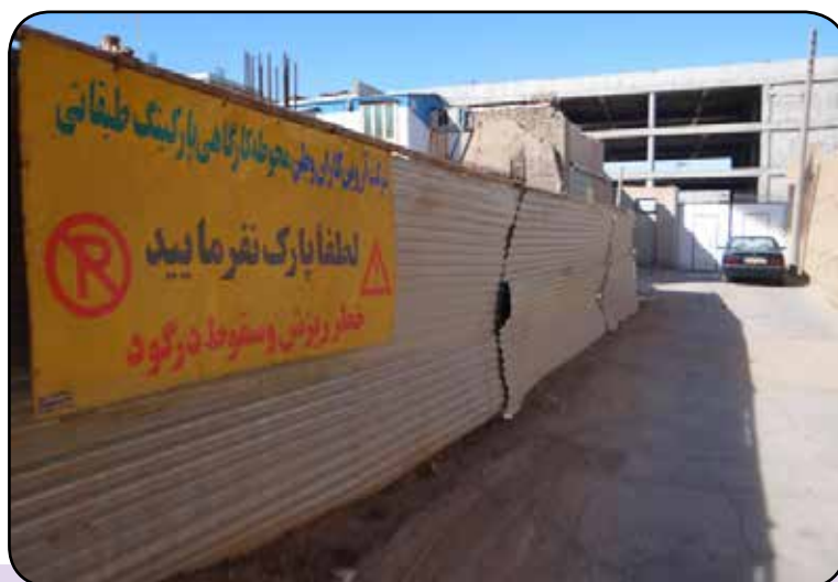
پارکینگ طبقاتی خیابان فرخی
