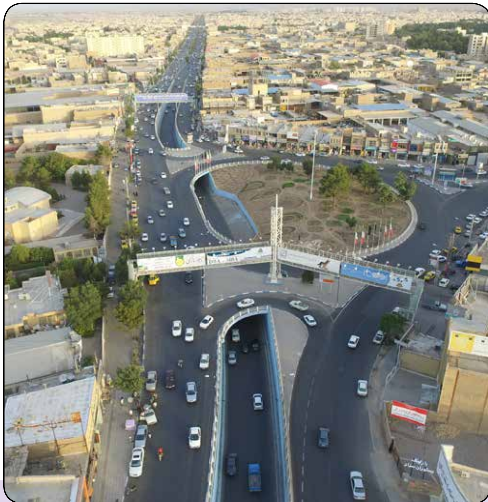
تقاطع غیر همسطح ابوذر
