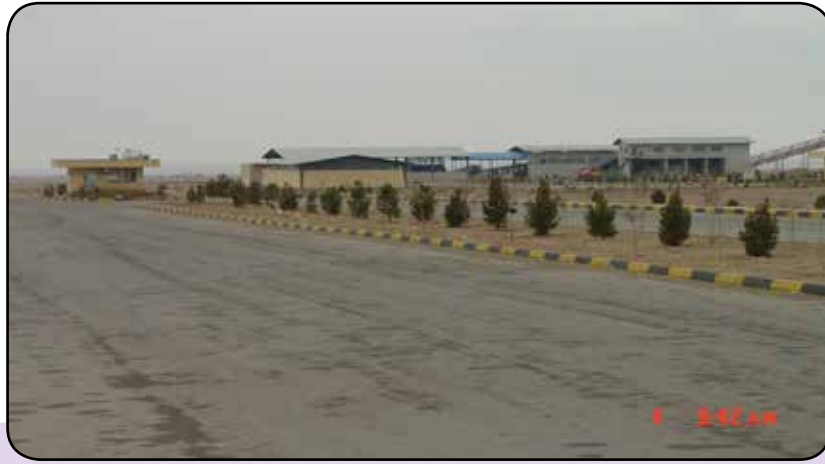
راه اندازی کارخانه پالایش پسماندهای خانگی
